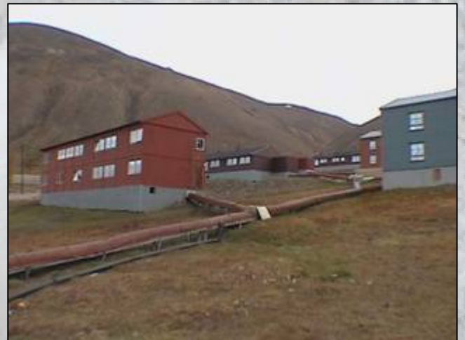
Longyearbyen: Door de permafrost liggen alle buizen en leidingen boven de grond.
